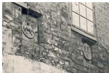
Engelsgrube 23: Wappen Stolterfoht
